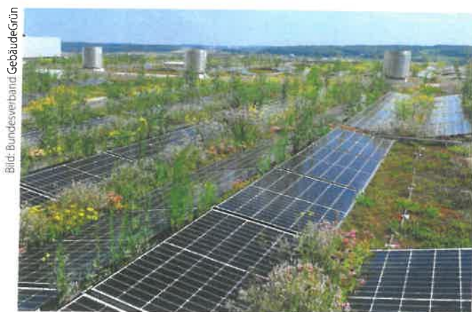
3 Schlechtes Beispiel, gutes Beispiel: Bei der nachträglich aufgebracht, auflastgehaltenen PV-Aufständerung im linken Bild reichen die Abstände nicht aus. Mustergültig dagegen die Installation rechts. Die Abstände der PV-Module zum Substrat sowie zwischen den Modulreihen sind ausreichend bemessen.
