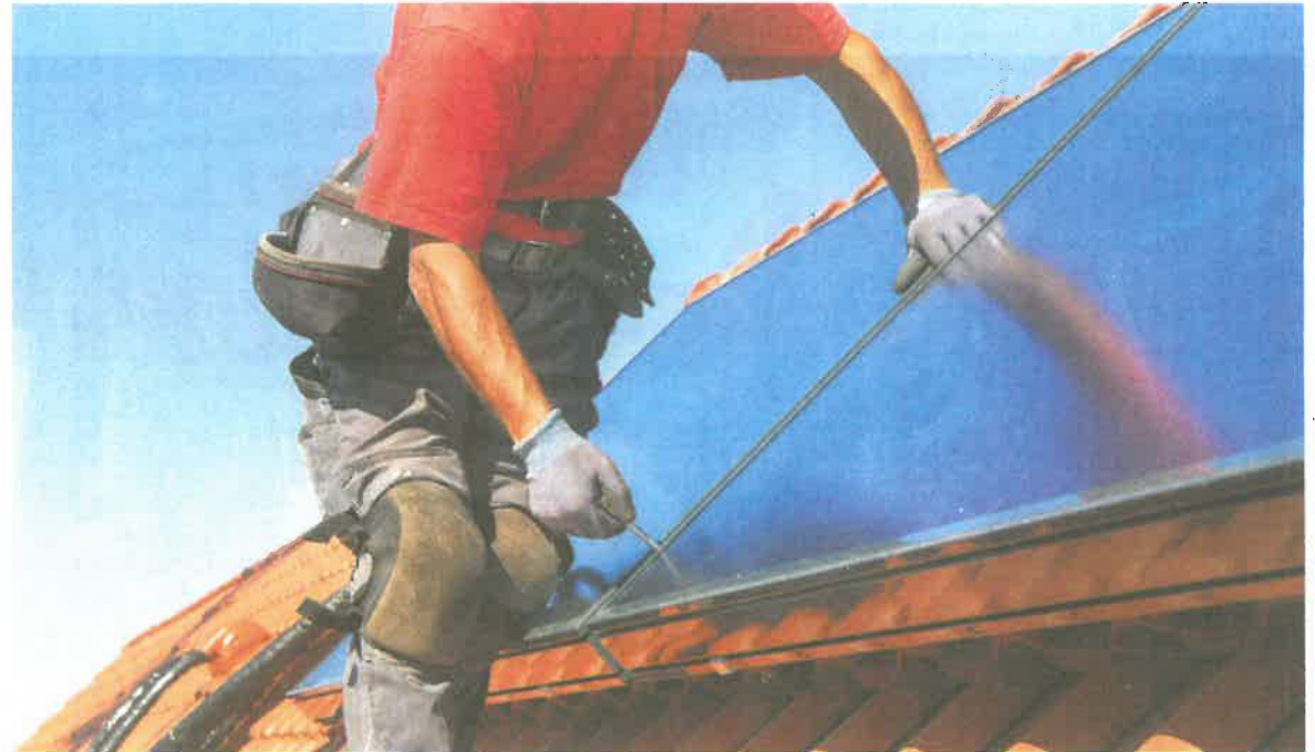
Montage einer Photovoltaik-Anlage: Wer sich eine Anlage zulegen möchte, sollte verschiedene Angebote einholen.
