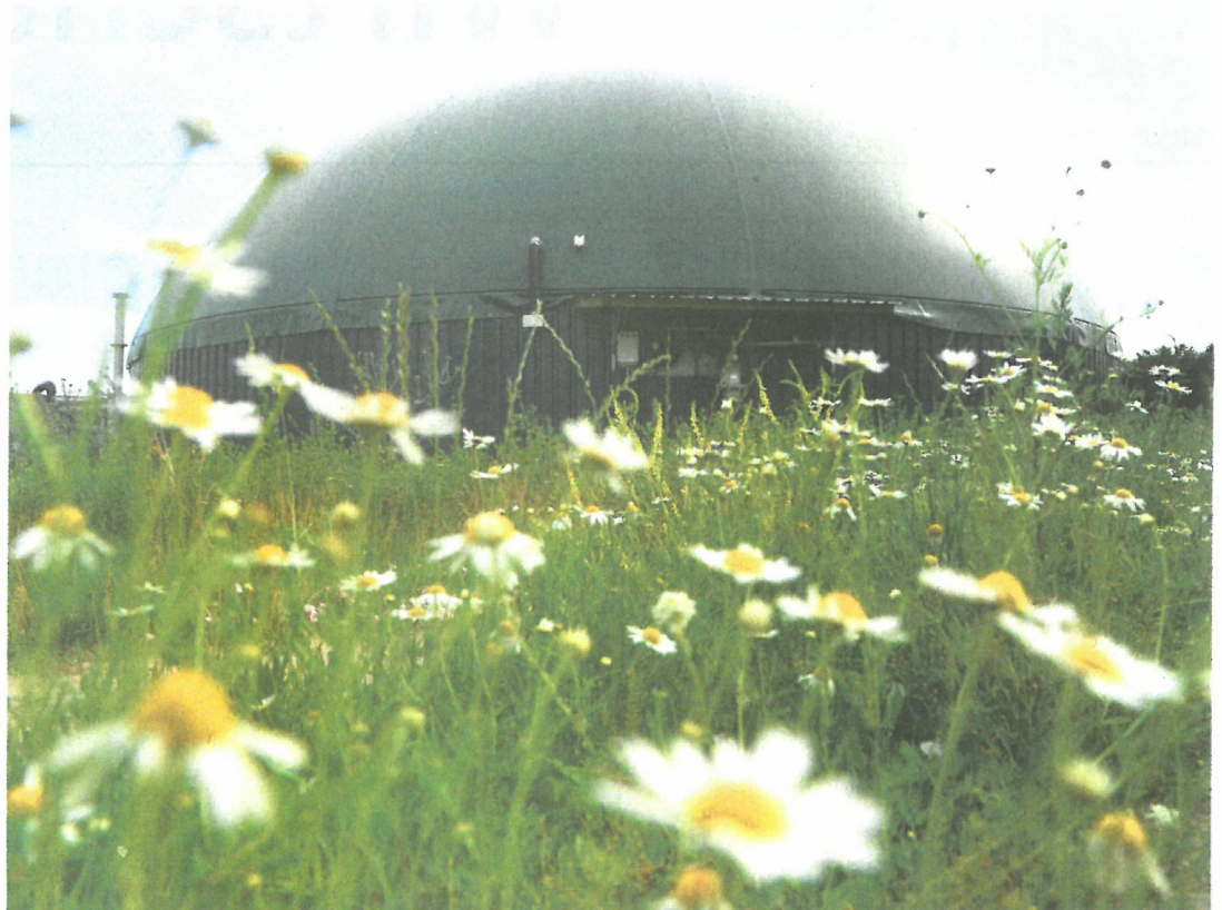
Heute wird Biogas wie hier in Brandenburg zumeist verstromt. Die Abwärme lässt sich in Nahwärmenetzen nutzen.
