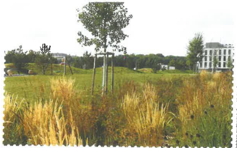
Im Veielbrunnepark in Stuttgart werden Dach- und Oberflächenwasser in einer Retentionsmulde gesammelt. Die große Verdunstungsrate wirkt dem Wärmeinseleffekt entgegen.
